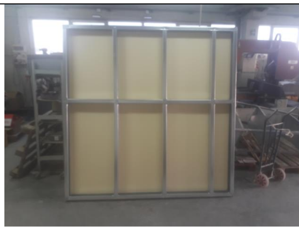
Vista estructura metálica
